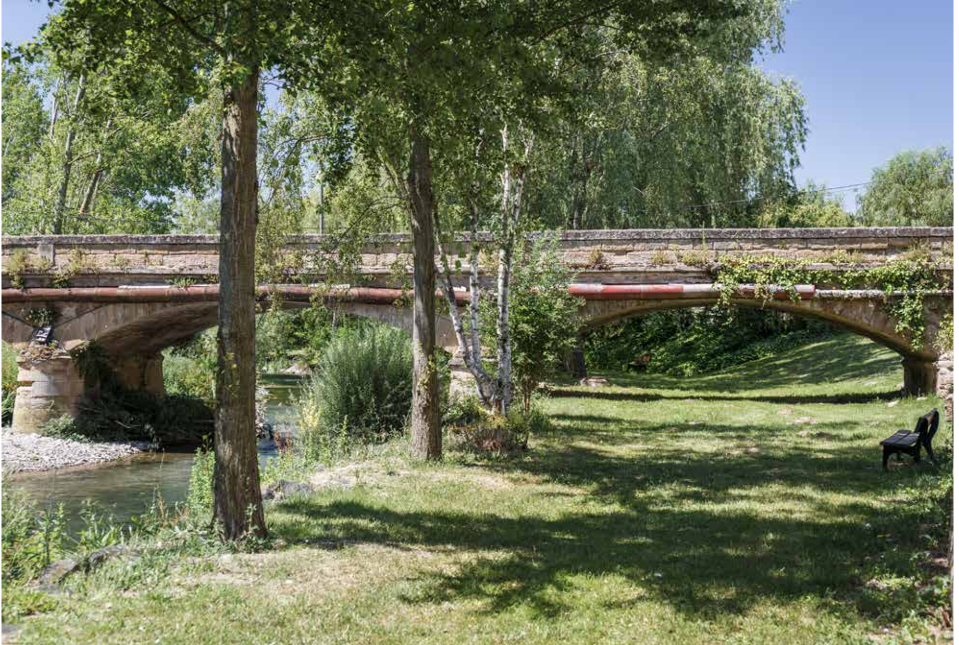
Parque El Plantío y puente sobre el río Tirón, a la entrada de la localidad.
