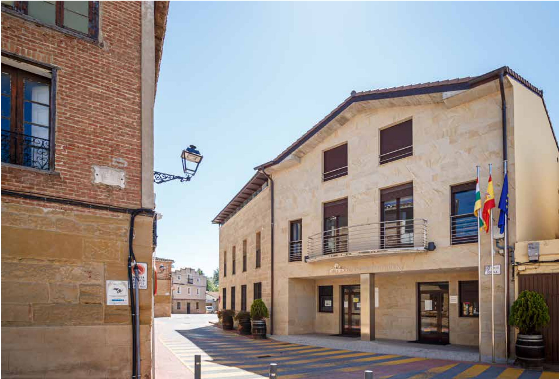
Nuevo edificio de usos múltiples: ayuntamiento, ciberteca, centro de mayores, biblioteca.
