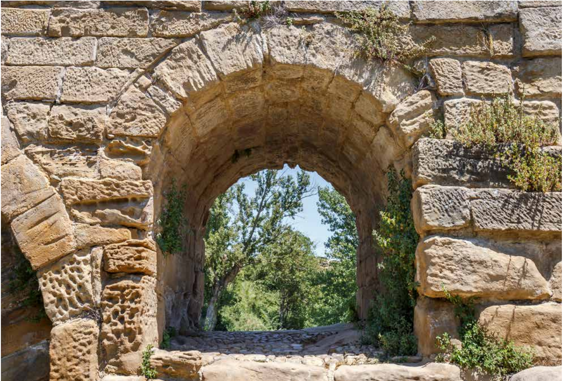
Detalle del puente romano.
