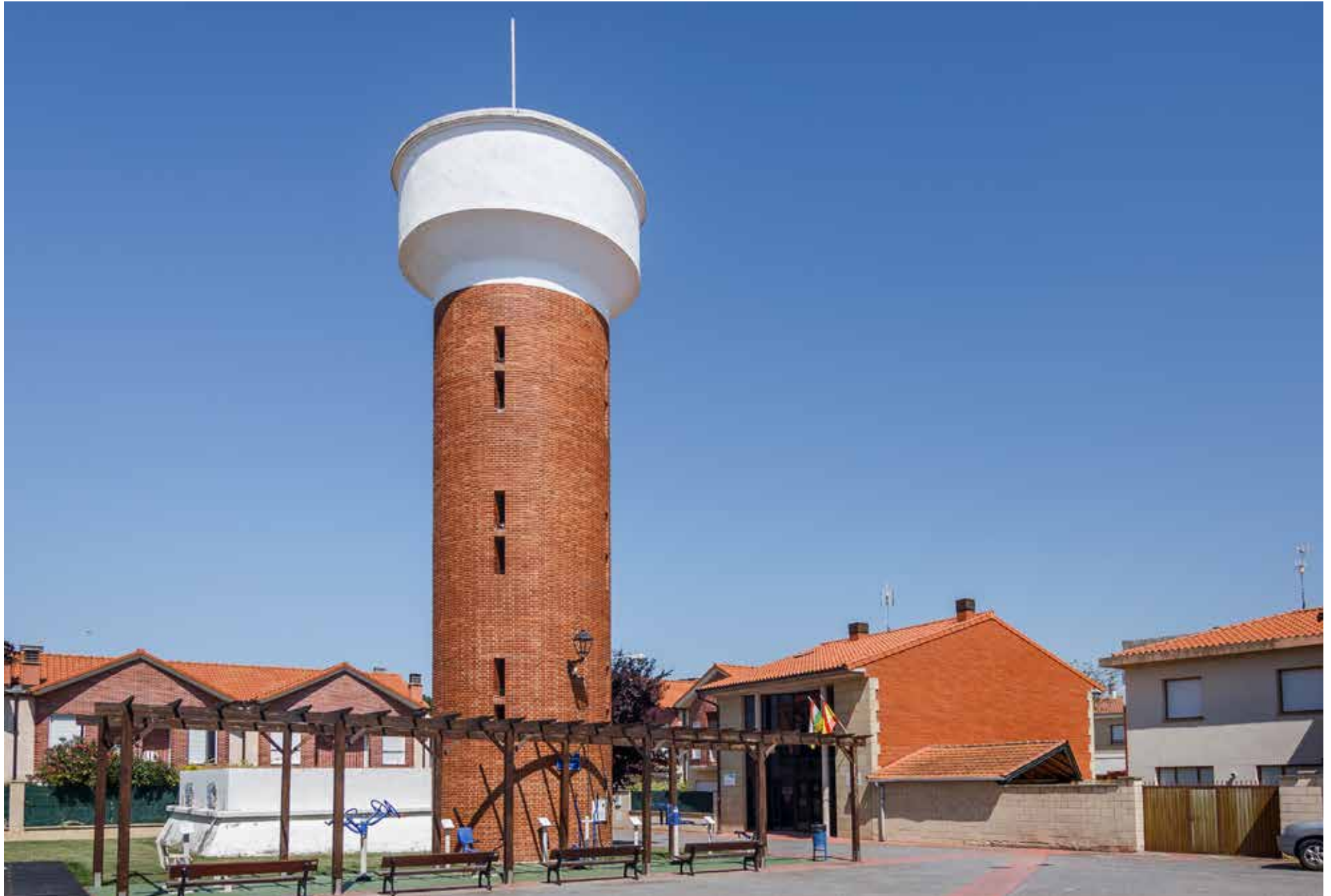
Antiguo depósito de distribución de aguas construido en 1968.
