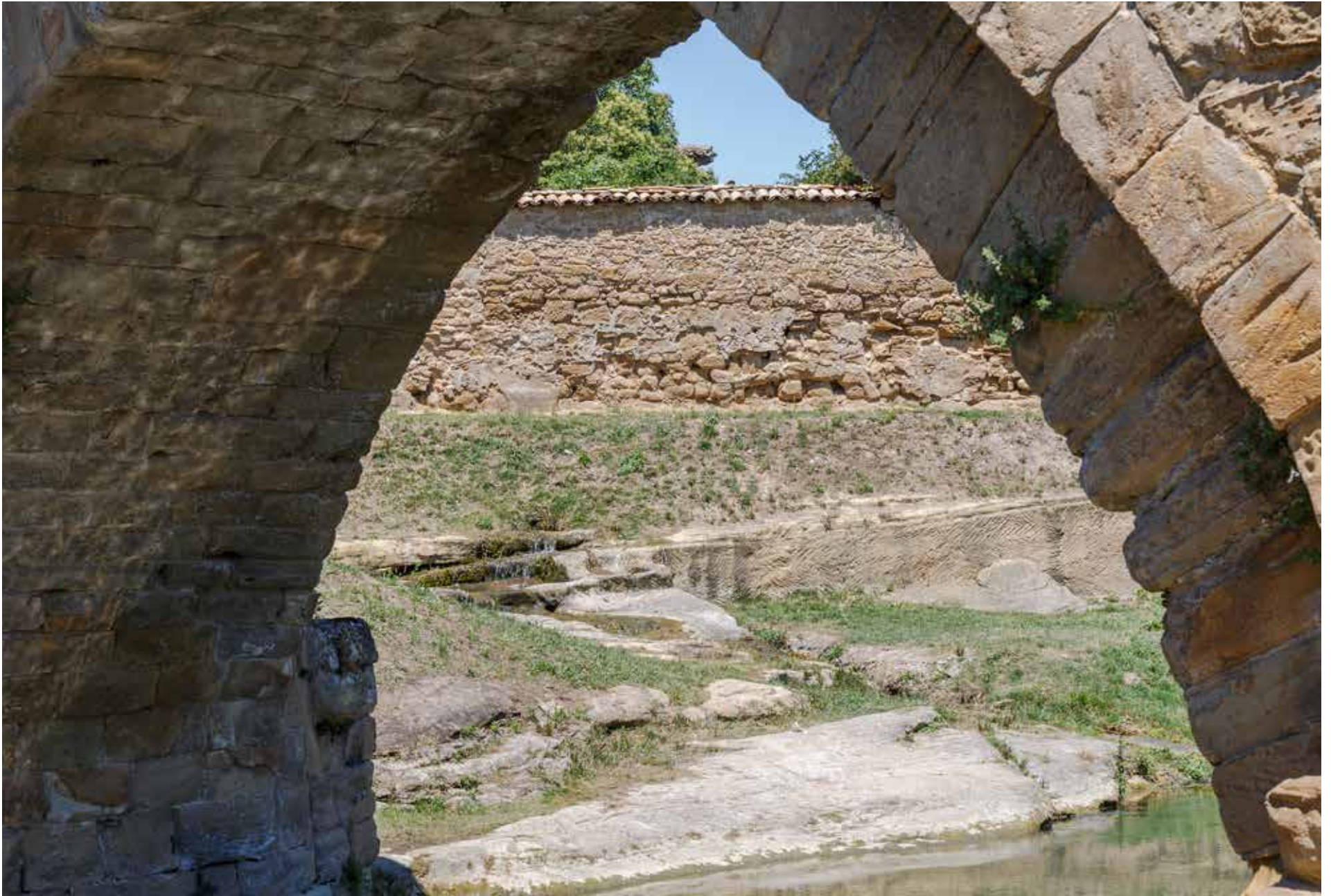
Aliviadero del puente con la fuente-lavadero al fondo.
