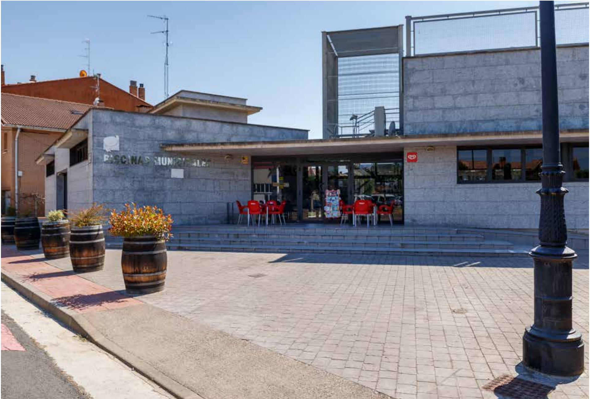
Acceso a las piscinas municipales de Cihuri.
