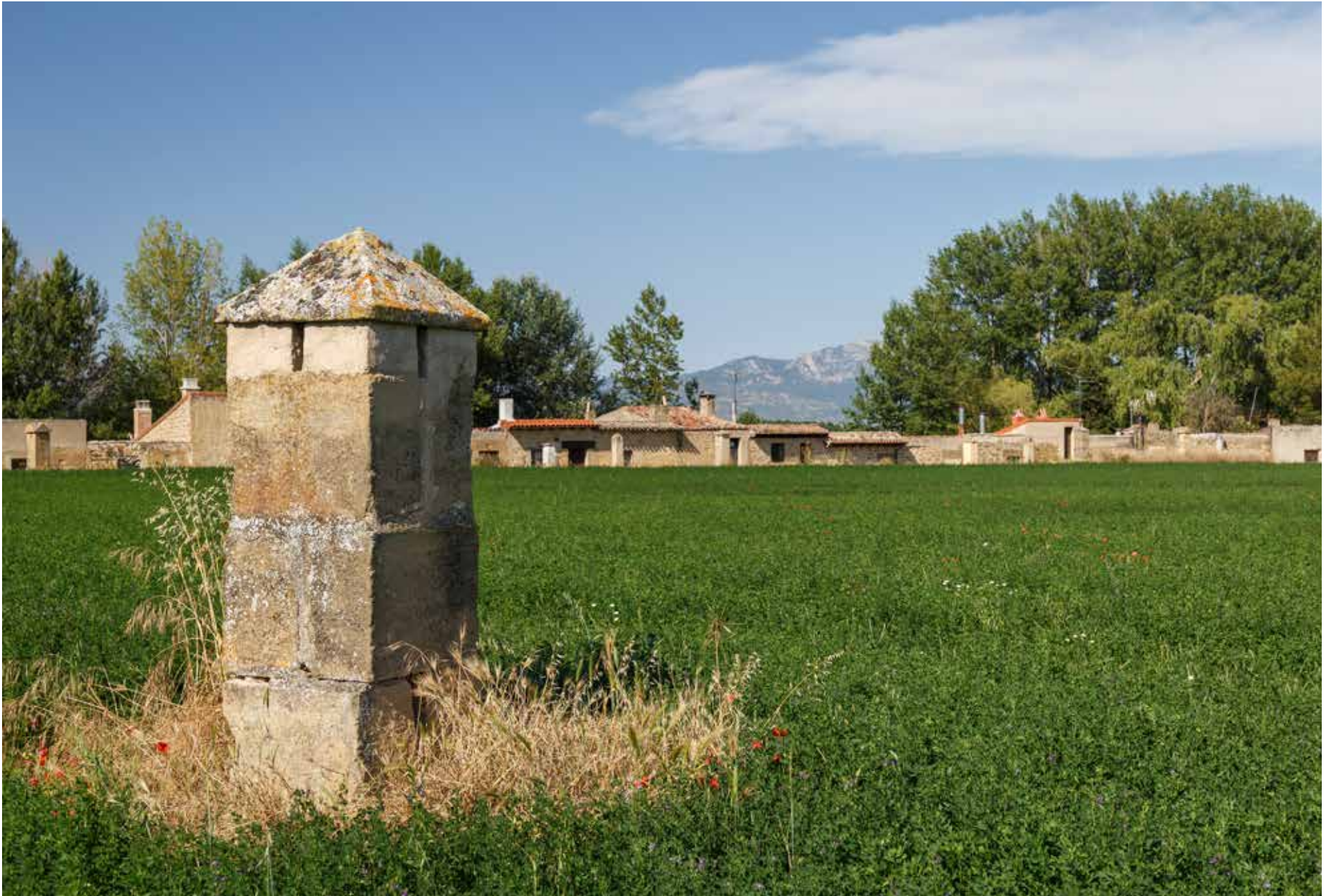
Tuferas-respiraderos para la salida del monóxido de carbono procedente de la elaboración-fermentación de la uva a vino.
