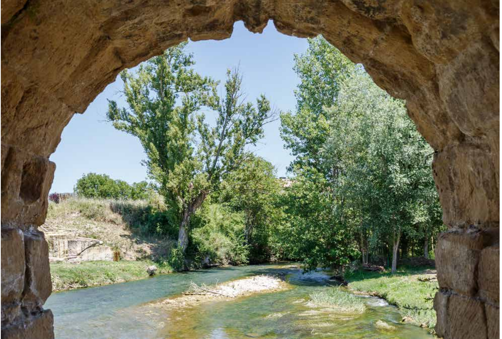
Vista desde uno de los aliviaderos del puente romano.
